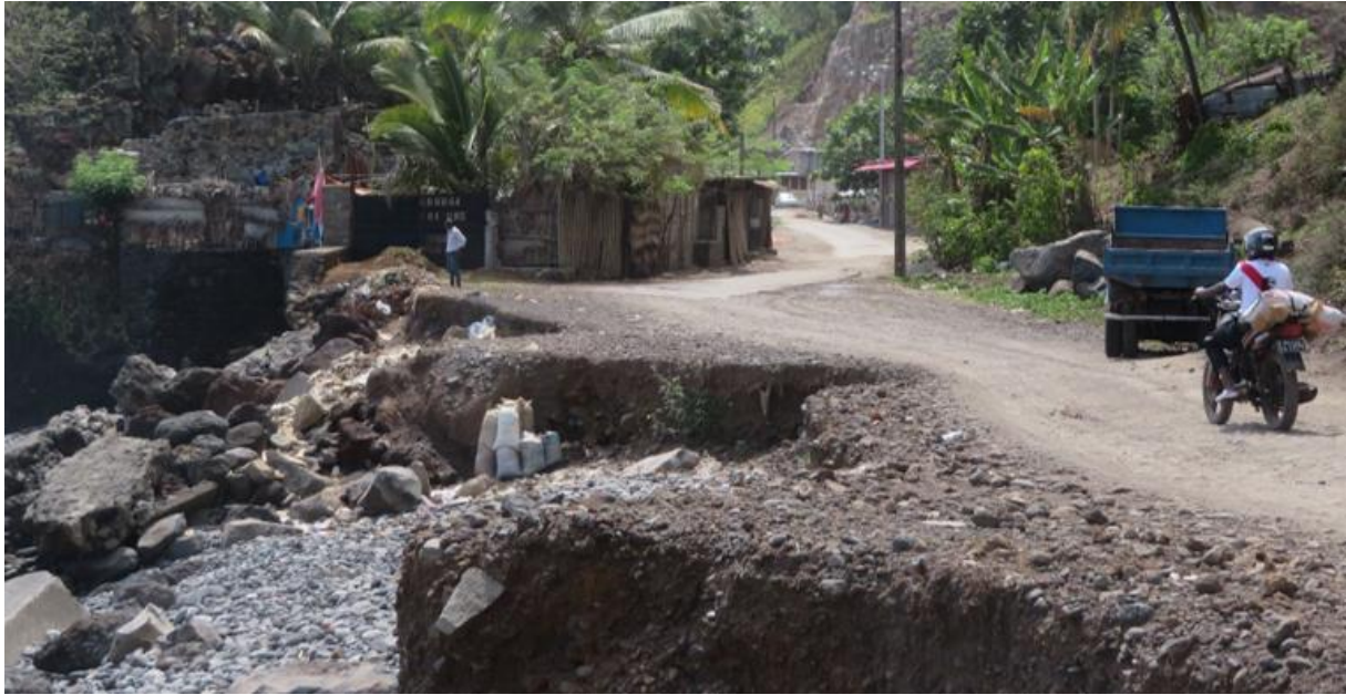
Figure 6: Infrastructure routier fragilisé par l'extraction de sable et galets de plages sur l'île d'Anjouan (Cliché de FakriDjambaé)
