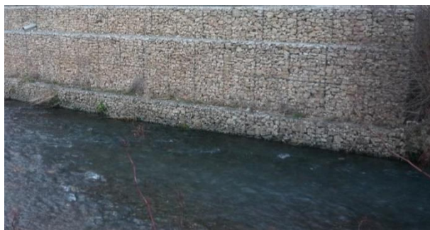
Figure 4: Photos de gabions déposés le long des berges d'une rivière
