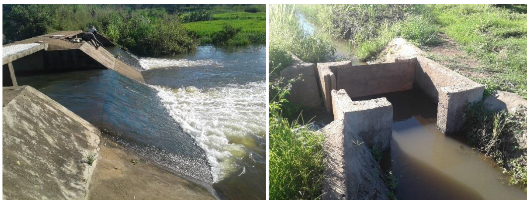
Figure n°1 : Petit barrage de retenue d'eau
