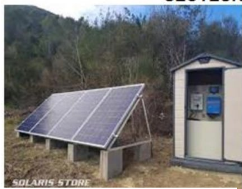
Panneaux Solaires photovoltaïques
