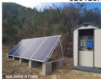
Panneau solaire photovoltaïque
