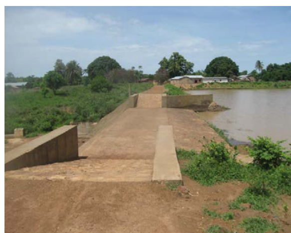
Digue et déversoir du barrage de Bêkêt
