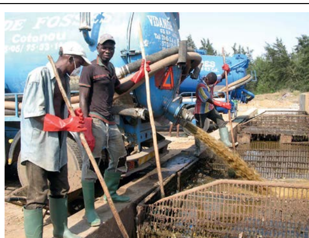
Vidange des camions vide-fosses à l'entrée de la station d'épuration des eaux usées de Sèmè-Podji 26
