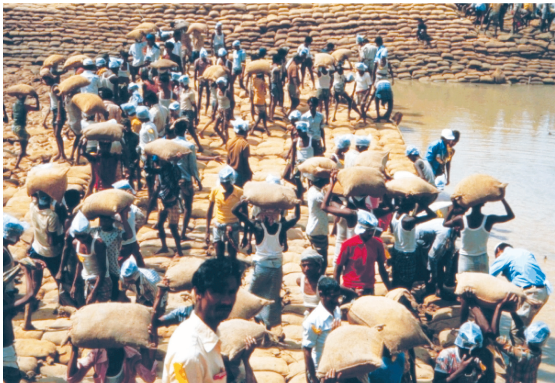
Figure 4.16: Barrage de retenue en construction sur la rivière de Jamuna, Bangladesh
