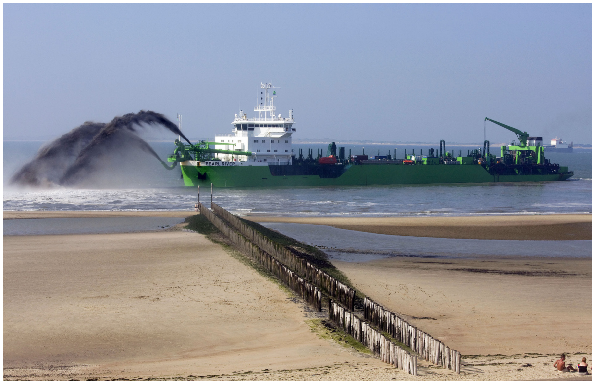
Figure 4.2: La méthode en « arc-en-ciel » de transfert des matériaux de reconstitution vers la plage
