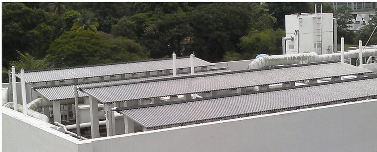
**BIPV, системы солнечного дома и солнечные зарядные станции.** Основная технология этих трех систем – ФЭ. Основное условие для использования ФЭ – освещенность местности солнцем и отсутствие затенения. Это необходимо потому, что ФЭ модули, особенно на основе кристаллического кремния, очень чувствительны к затенению. Рассмотрим для примера модуль, состоящий из 36 ФЭ элементов. Если один из элементов затенен, он не будет вырабатывать
