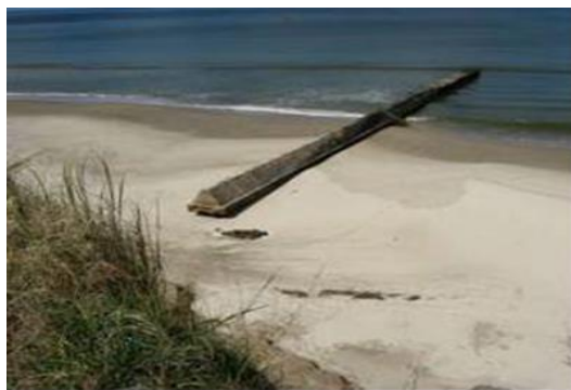
FIGURA 3: ARENA RETENIDA POR EL ESPIGÓN EN COMPARACIÓN CON LA PLAYA EROSIONADA E INDICADOR DEL RETROCESO DE LA BARRANCA (LA FLORESTA, CANELONES, URUGUAY)
