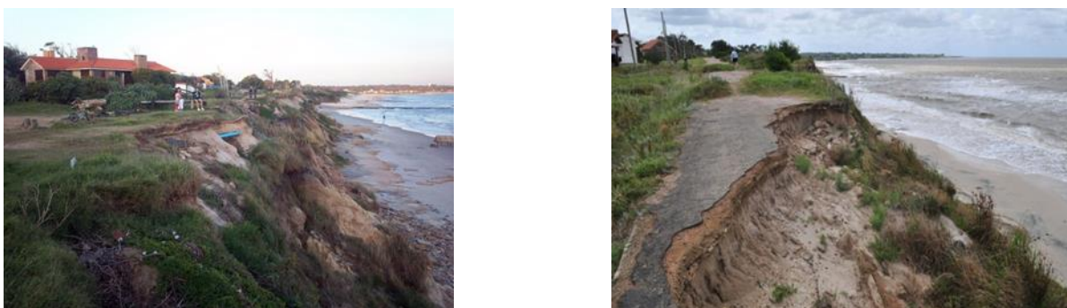
FIGURA 2: IMPACTO DE LA EROSIÓN COSTERA SOBRE VIVIENDAS E INFRAESTRUCTURA VIAL A LO LARGO DE LA COSTA (LA FLORESTA, CANELONES, URUGUAY)
