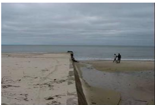
FIGURA 3: ARENA RETENIDA POR EL ESPIGÓN EN COMPARACIÓN CON LA PLAYA EROSIONADA E INDICADOR DEL RETROCESO DE LA BARRANCA (LA FLORESTA, CANELONES, URUGUAY)
