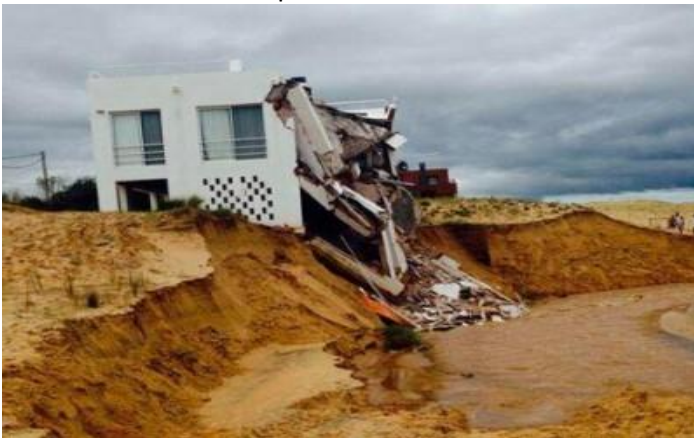
Foto 2: Efectos del temporal de Febrero 2014 en infraestructura turística, Rocha
