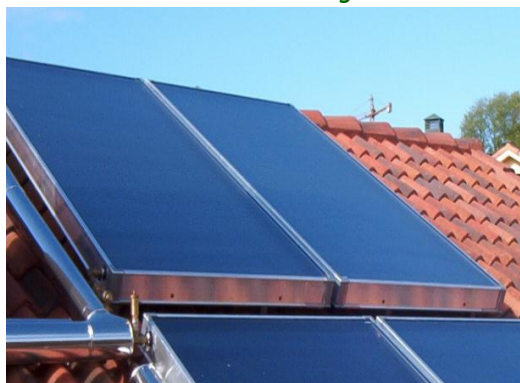
Figura 3: Foto de paneles solares térmico.
