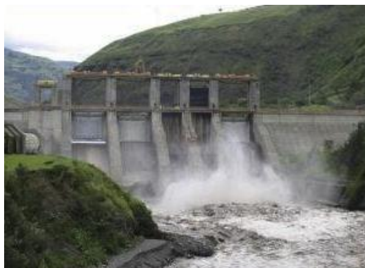
Figura 7: Se está construyendo una mini hidroeléctrica comercial en la comunidad Paso Bajito en Jarabacoa, la cual tendrá un costo aproximado de US$10 millones y generará cuatro megavatios al sistema eléctrico interconectado.
