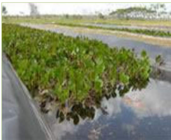
Figura 3: Saneamiento de aguas residuales en la provincia de San José de Ocoa, basado en fitodepuración, a través de construcción de filtros con macrofitas flotantes. Ver en http://www.fundacionglobalnature.org
