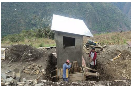
Figura 9: Obreros construyendo letrinas de arrastre hidráulico. En 2000, el INDRHI, a través del proyecto "Micronizao" de la ONAMAC construyó 15 letrinas para la población cercana a la microcuenca el Calimete de la cuenca Nizao.
