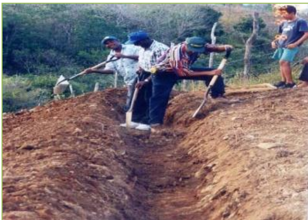
Figura 22: Práctica de conservación utilizando la técnica de zanjas de laderas, consistente en la construcción de un canal a través de la pendiente del terreno a unos intervalos definidos en su diseño, con o sin barreras vivas para detener o controlar el flujo del agua y conducirla hacia un desagüe protegido y reducir la erosión a cantidades permisibles, el objetivo de esta práctica es cortar la longitud de la pendiente, interceptar al agua de escorrentía, aumentar la infiltración de agua en el terreno y reducir la erosión del suelo. Esta práctica fue aplicada en Jánico, La Vega (Guarey), Padre Las Casas, Ocoa.
