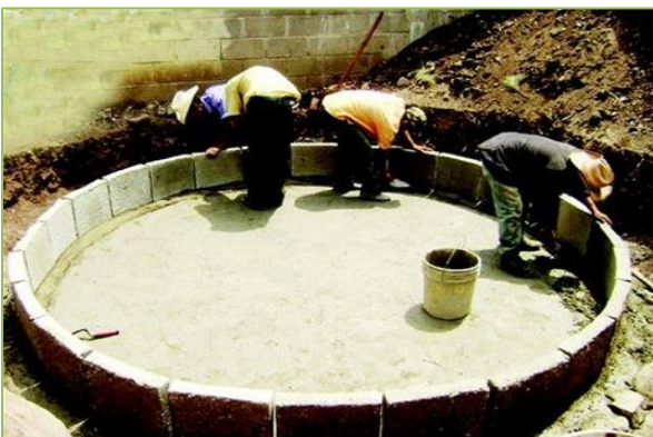
Figura 6: Proceso instalación tanque para captación de agua de lluvia. En 2009, el INDRHI, a través del CEHICA y con el auspicio de PHI-UNESCO, a través del Centro del Agua para Zonas Áridas y Semiáridas de América Latina y el Caribe (Cazalac) capacitaron a sus técnicos en la tecnología SCALL (por sus siglas en inglés), conjuntamente con representantes de Antigua & Barbuda, Haití, Barbados, Jamaica, St. Lucía, St. Kitts – Nevis y Cuba. Ver en: http://www.listin.com.do/la-republica/2009/12/13/124746/De-vuelta-al-uso-de-los-aljibes .
