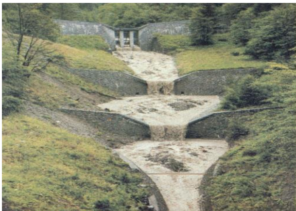
Figura 26: Práctica de conservación utilizando la técnica de estructuras de azolves, con el objetivo de amortiguar el impacto del flujo hídrico en bruscos cambios de pendiente y en las riberas de cursos de agua; disminuir la velocidad de las aguas y limpiar las impurezas y filtrar los sedimentos en los flujos hídricos
