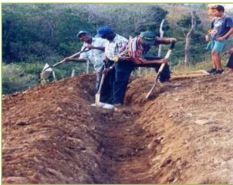
Figura 15: Práctica de conservación suelos utilizando la técnica de zanjas de laderas, fue aplicada en Jánico, La Vega (Guarey), Padre Las Casas, Ocoa. Fuente: Dirección cuencas MMARN.
