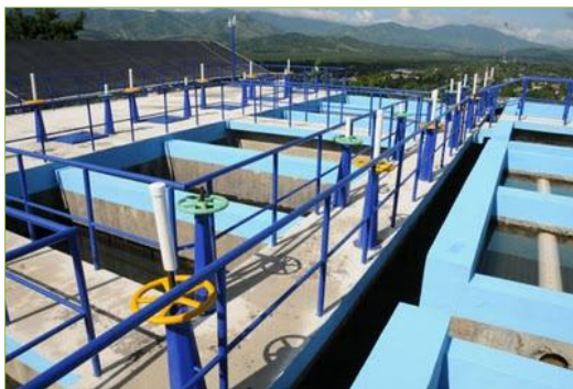
Figura 7: Vista del acueducto inaugurado en 2011 por INAPA en Villa Altagracia, Provincia San Cristóbal. Cuenta con una planta de tratamiento de filtración rápida con capacidad para 200 litros por segundo, con generador de emergencia de 30 kilovatios. También tiene un depósito regulador de hormigón armado con capacidad para un millón de galones y otro metálico superficial de 300 mil galones y 7 mil 185 acometidas familiares. Ver en: http://www.noticiassc.com/2011/11/inapa-inaugura-sistemas-de-agua.html .
