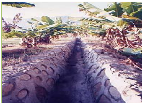
Figura 29: Práctica de conservación utilizando la técnica de canales de desviación, consistente en canales de sección transversal, generalmente trapezoidal, los cuales deben ser calculados y diseñados individualmente para las condiciones en que van a trabajar, construidos a través de la pendiente. El objetivo es interceptar el flujo de agua de escorrentía y desviarla a sitio seguro para proteger los cultivos, sistemas de terrazas, áreas inundables, áreas urbanas, etc. y para desviar escorrentía para aprovecharla en áreas adyacentes.
