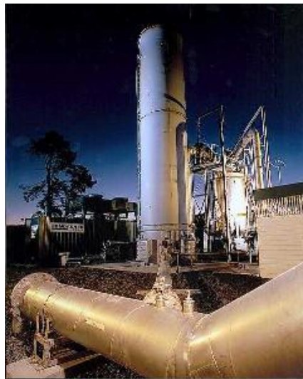
Figura 4.7. Sistema de evaporación de lixiviados y posterior combustión
