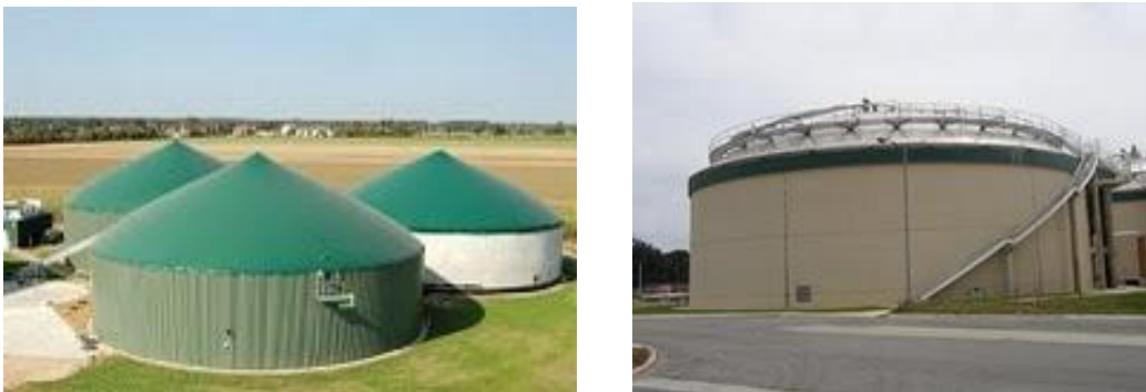
Figura 4.11. Digestores tipo mezcla completa con membrana (izq.) y mampostería (der.)
